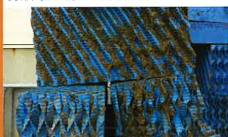
SURFACE D'ÉCHANGE EMBOUÉE
