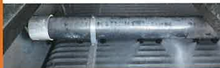
SURFACE D'ÉCHANGE EMBOUÉE
