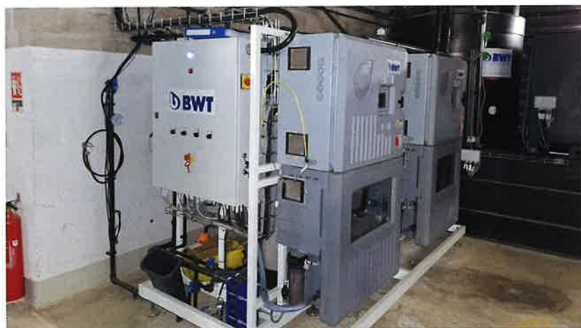
BWT propose, par exemple, le générateur ECO-MX qui fournit, en continu, par électrolyse de sel, une solution chlorée désinfectante et fraîche.
